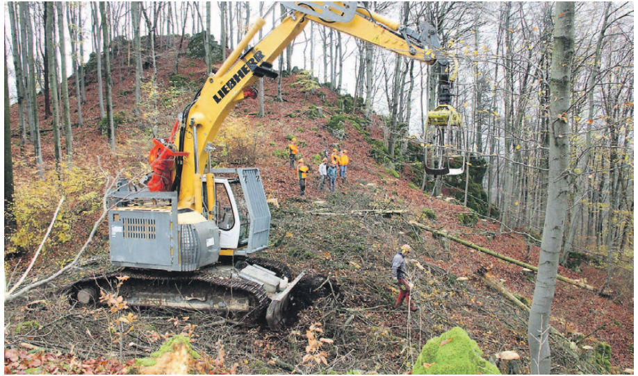
Mit Hilfe eines Seilbaggers wurden die gefällten Stämme waldschonend bergaufwärts gezogen.
